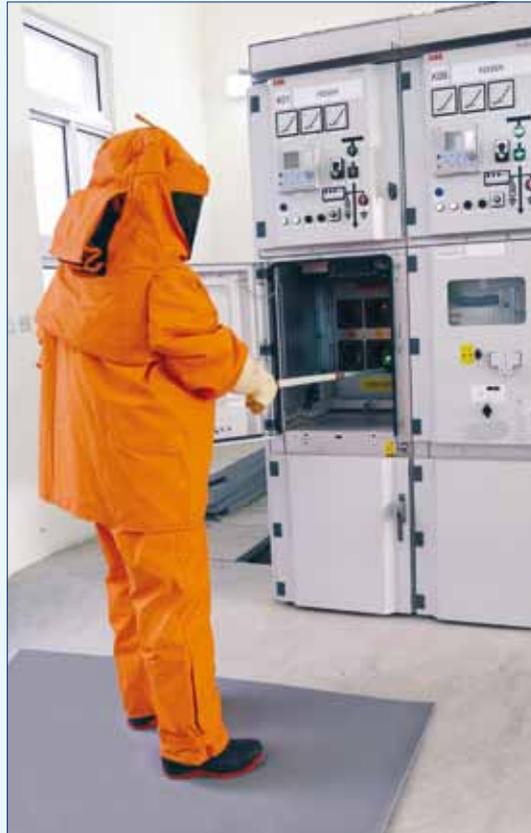
البدلة الواقية من القوس الكهربائي (ARC - FLASH)
